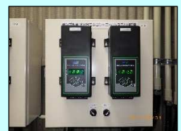
TKS設置完了
