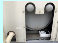
漏洩検知装置取付
