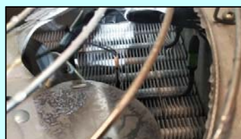
補助温度センサ取付
