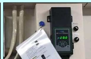
本体取付完了
